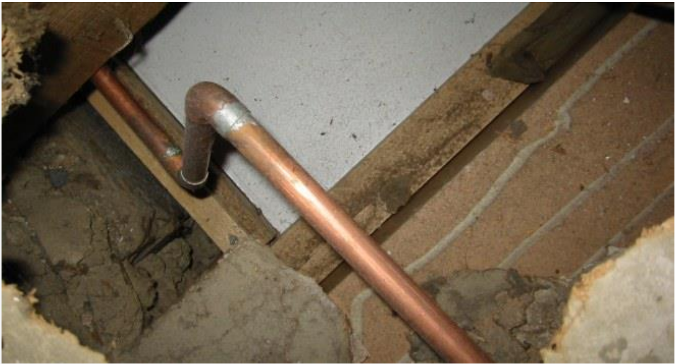
Прокладка медного водопровода под полом строящегося дома
